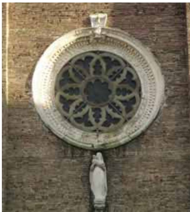
a fianco: Rosone della chiesa di S. Tomaso
